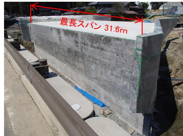
完成写真(左岸上流より)
