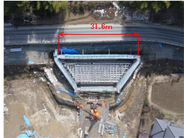
全体構造(施工時に上空から撮影)
