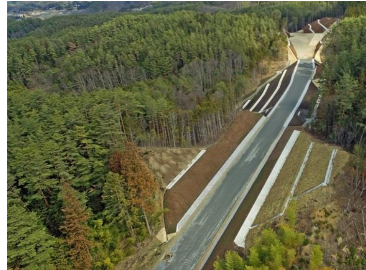
全体構造（施工時に上空から撮影）
