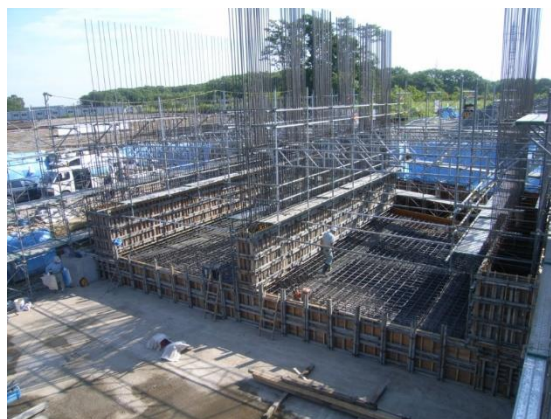
先行壁体部型枠組立完了
