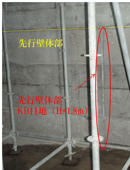
側壁部の先行壁体部の目地の状況
