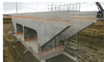
写真5 ■ 国土交通省北海道開発局が発注した工事でNDR(枠部分)を採用した例。図体の側壁だけでなく、高欄の下端にも使った。(写真:玉川橋)
