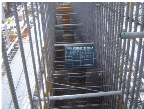
収縮低減目地設置完了
