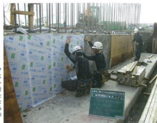
写真4 ■ 柱部のコンクリートを、脱型直後も水分の蒸発を防ぐシートを張って2週間以上養生した。NDRを打設した部分は色がやや異なるもの、埋め込まれる範囲なので美観上の問題はない。
