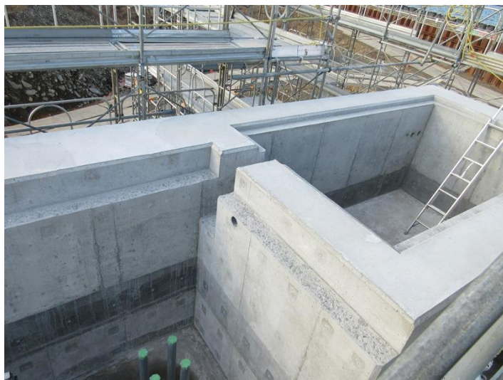
施工状況(豎壁)
