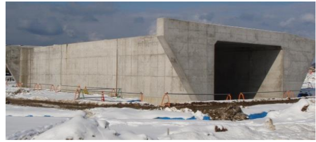
長野県発注「平成18年度国補住宅市外地基盤整備工事」
