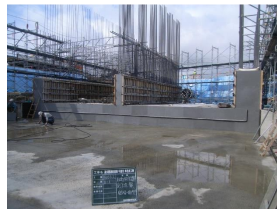
先行壁体部の型枠脱型状況
