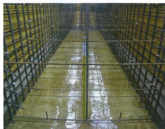
写真3 ■ NDRを打設する梁底部の側面。型枠内には、余剰水の析出を防ぐ透水性シートを張った。(写真右も西海建設)
