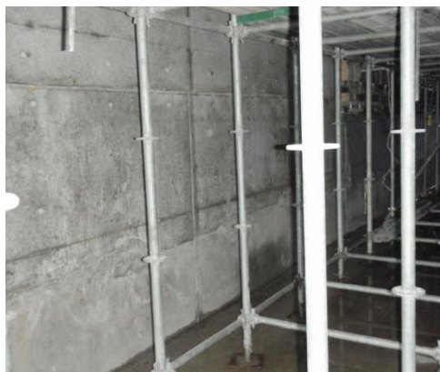
収縮低減目地設置完了
