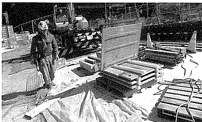
SDPパネル吊り上げ(今戸高架橋)
