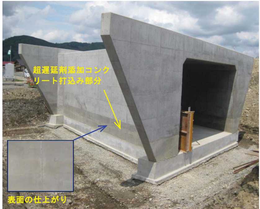
写真-5 完成した函渠工の外観
