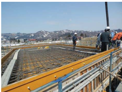
写真-4 コンクリート打込み
