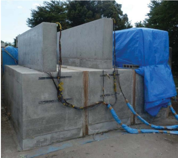
写真-1 供試体の保温養生の実施状況
