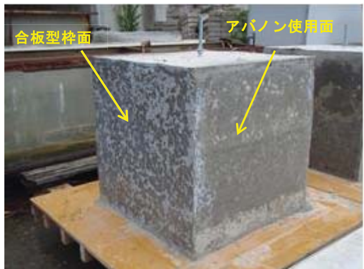
写真-2 コンクリート表面の外観の比較
