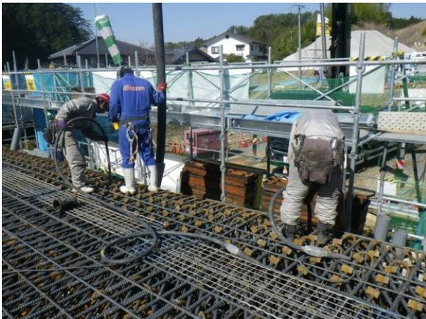
写真-3 側壁のコンクリート打込み状況
