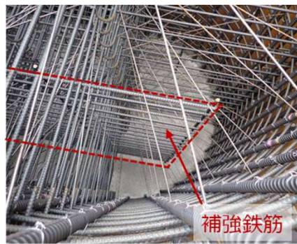
▼補強鉄筋の配置状況
