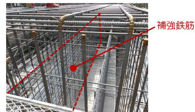
▼補強鉄筋の配置状況
