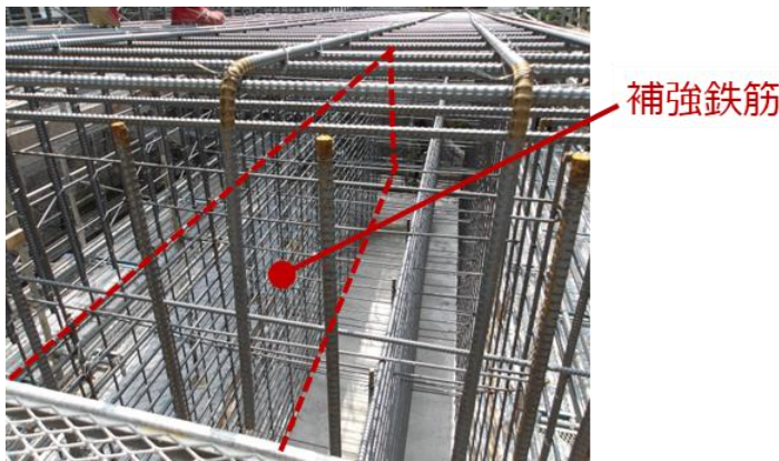
▼補強鉄筋の配置状況
