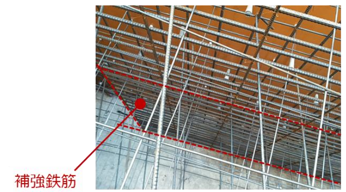
▼補強鉄筋の配置状況
