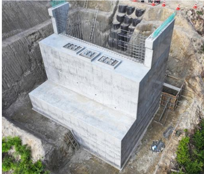
▼補強鉄筋の配置状況
