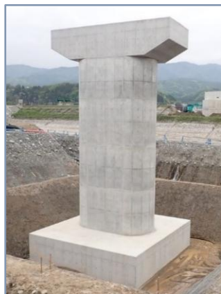
構造物 : 橋脚 壁厚 : 3.6m 施工場所 : 長野県
